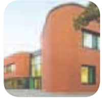
Tour 7: Neubau Grundschule In der Steinbreite 54 30455 H-Davenstedt
