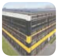
Tour 4: Altbau Büro-, Fertigungs- und Lagergebäude Nennendorfer Chaussee 9 30453 H-Bornum
