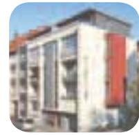
Tour 2: Neubau Mehrfamilienhaus An der Strangriede 10 30167 H-Nordstadt
