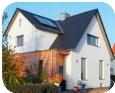
>> Nach der Modernisierung
