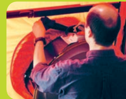
>> Einbau des Ventilators beim Luftdichtheitstest
