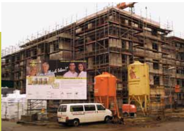
Gebäude für betreutes Wohnen in der Käthe-Steinitz-Straße, Spar- und Bauverein eG
