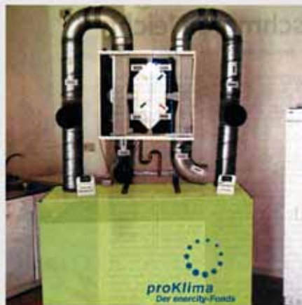
So sieht ein automatischer Lüftungsanlasser mit Wärmerückgewinnung aus.
