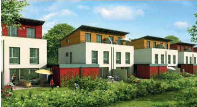
Passivhäuser der Firma Gundlach im Niebüller Weg
