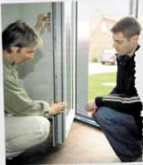
Wie Bauherr zu Realisierungszeit. Wie sich eine wohnungswille in, auch die sein muss und welche Fensterarten zum Einsatz kommen. Rund die rund 800 Besucher zum Passivhausfest in zwölf vers-amen Anwohnungsprojekten.
