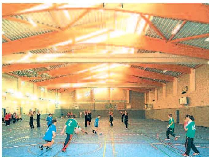
Albert-Einstein-Schule, Turnhalle im Passivhausstandard
