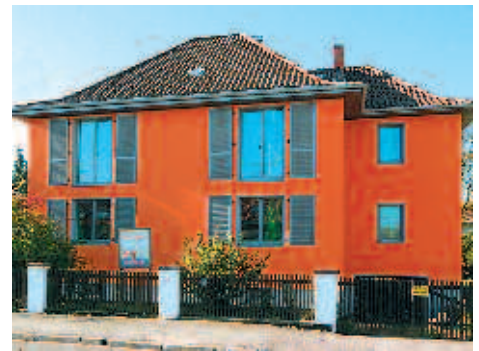
Altbau mit Fassadendämmung und Passivhausfenstern, Ronnenberg
