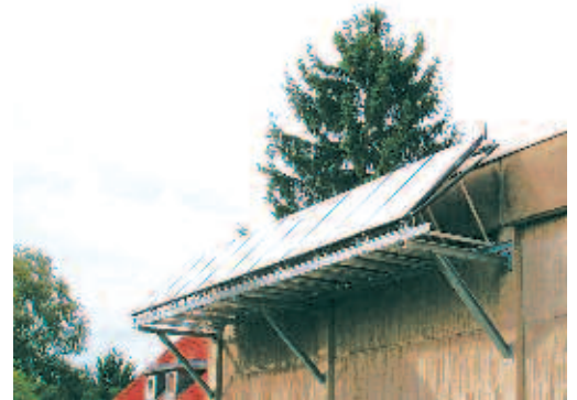
Fassadenmontage der Sonnenkollektoren, Turnhalle Seelze
