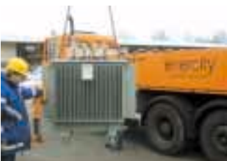
Transformatoren-Austausch, Stadtwerke Hannover AG
