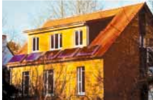
Thermische Solaranlage, Familie Hufnagel
