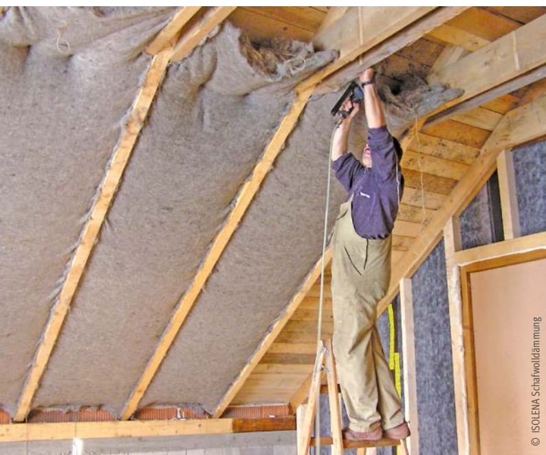
Dachdämmung mit Schafwollmatten
