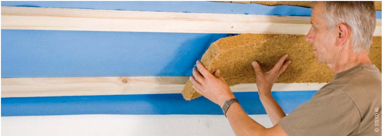
Ausfüllen der Installationsebene mit Holzfasermatten
