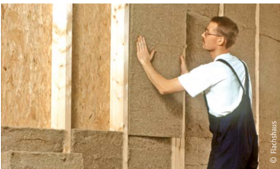
Ausfachung von Ständerwerk mit Flachsmatten
