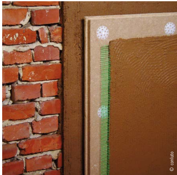
Innendämmung mit Holzfaserdämmplatten
