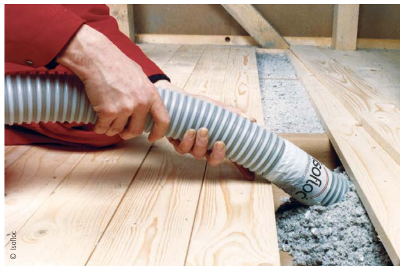
Einblasdämmung als Wärme- und Luftschalldämmung unter Fußböden
