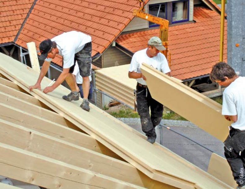
Wärmebrückenfreie Aufsparrendämmung mit wasserabweisenden Holzfaserdämmplatten
