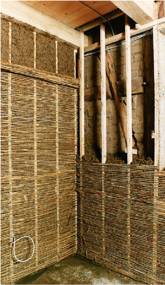
Konstruktion für eine Dämmschüttung
