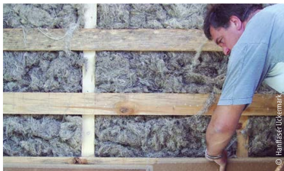
Innendämmung mit Hanfstopfwohle und verputzbarer Holzfaserplatte
