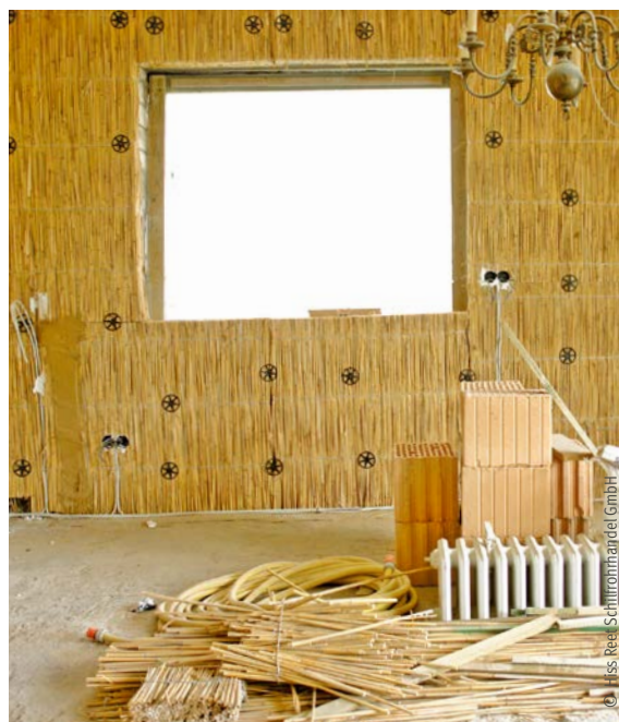
Mit Schilfplatten gedämmter Innenraum
