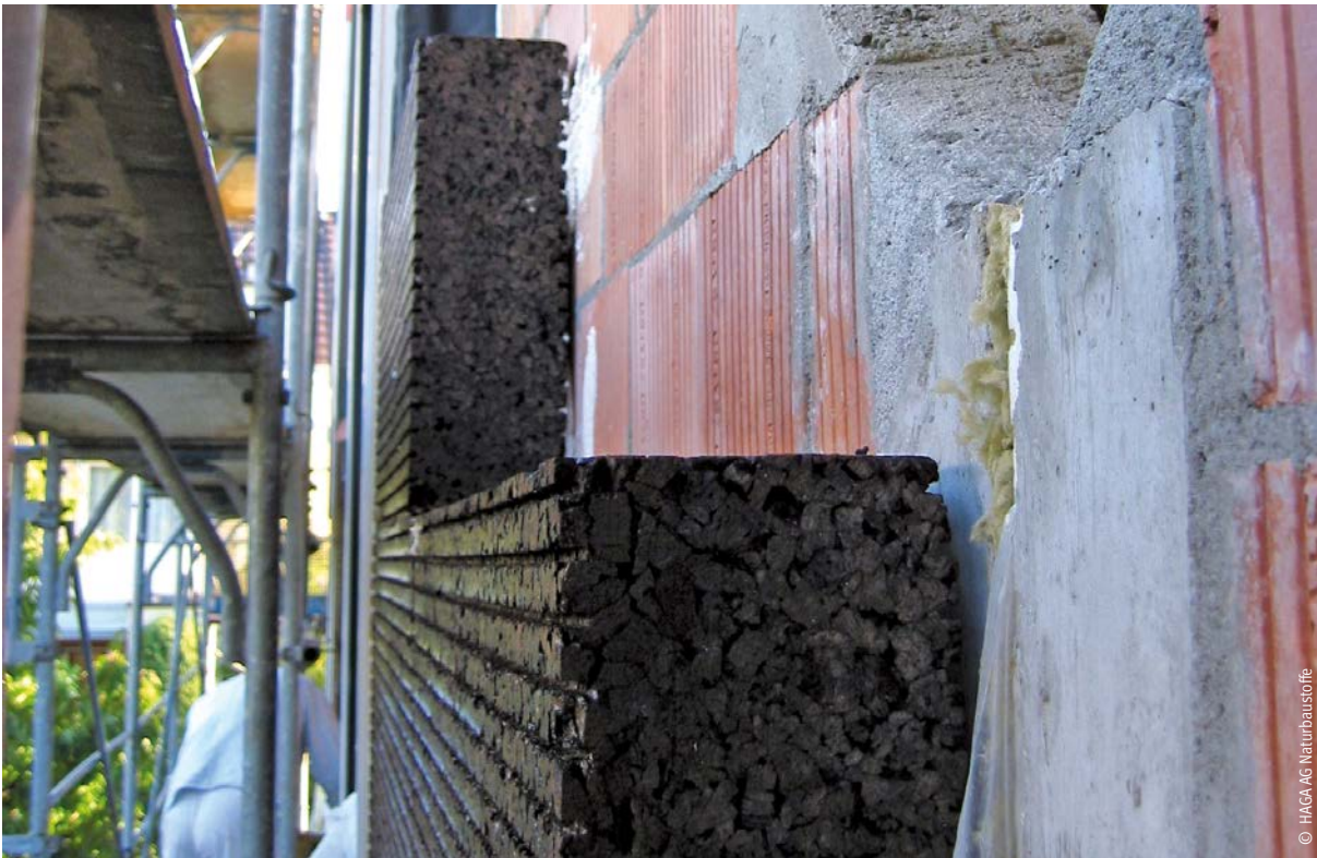
Korkdämmplatten als Fassadendämmung
