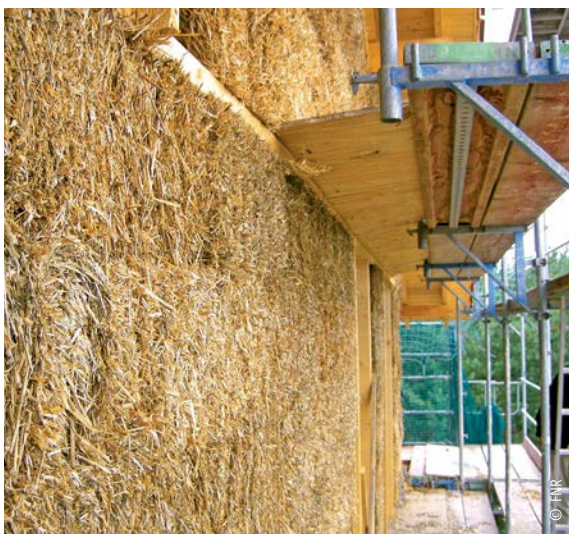
Stroh zwischen einer Holzrahmenkonstruktion (außen)
