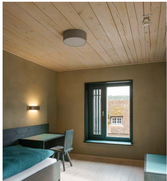
Fassadenausschnitt | Gästezimmer Deckenuntersicht – Balken mit ihren Kernen und Rissen eine sehr schöne Untersicht der Mann an Mann Decke
