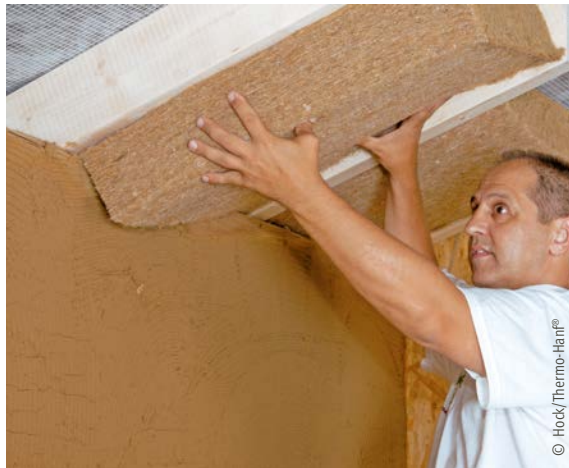
Dachdämmung mit Hanffasermatten
