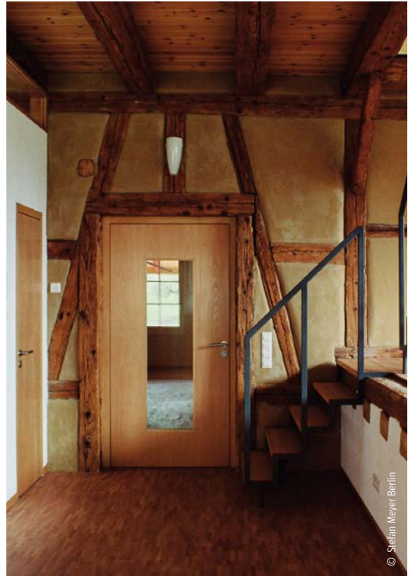
In Altbauten müssen konstruktive Holzbauteile von Feuchtigkeit entlastet werden. Lehmverputz eignet sich hierfür hervorragend. (Umbau Fachwerkscheune in Lottstetten-Balm; Architekt: C. Kaiser)
