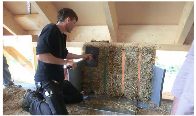
Strohballeneinbau zwischen die Holzständer im Dachgeschoss
