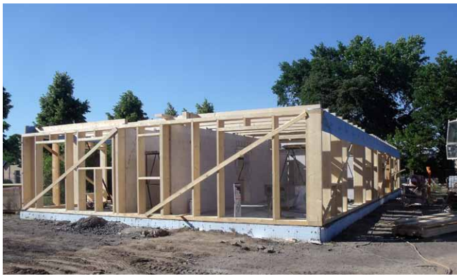
Holzständerwerk des Erdgeschosses
