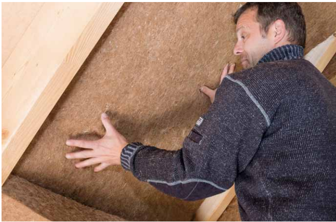
Die Dämmstoffe aus Jutefasern wurden 2-lagig versetzt zwischen den Sparren eingebaut
