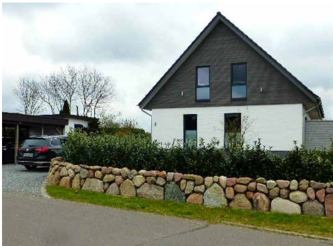
Außenansicht nach der Sanierung
