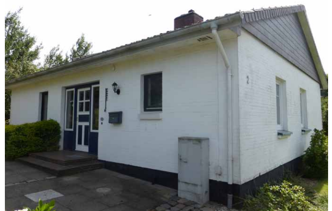
Das Haus vor der Sanierung
