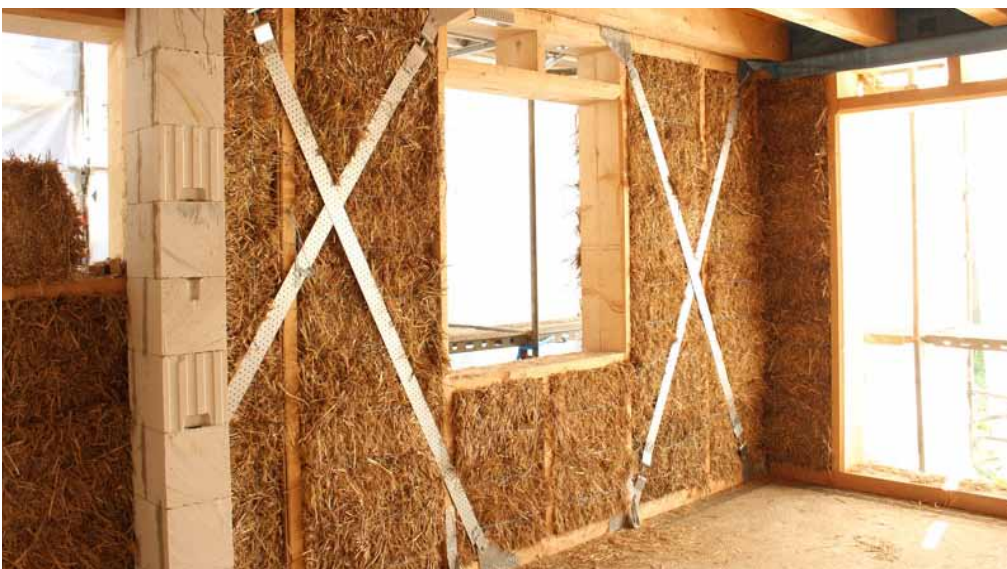
Fertig ausgefachtes Holzständerwerk mit Strohballen, gesichert mit Rispenbändern
