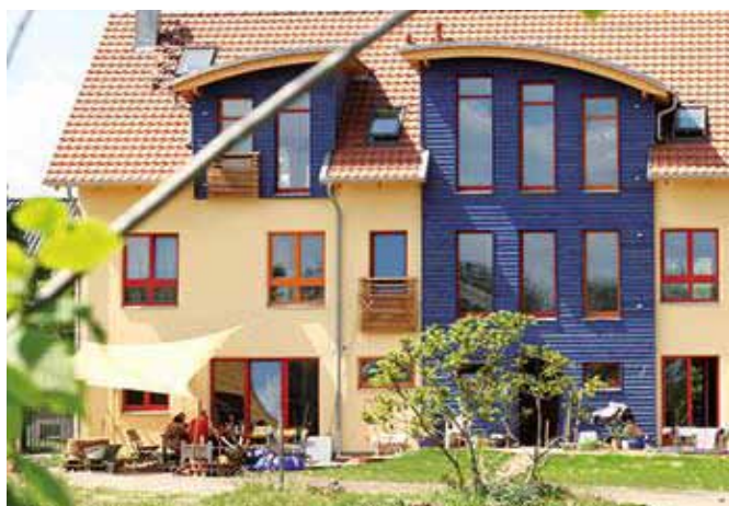
Außenansicht von der Hofseite
