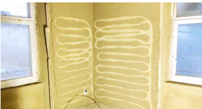
Lehm - ideal für Wandheizung (vorher)
